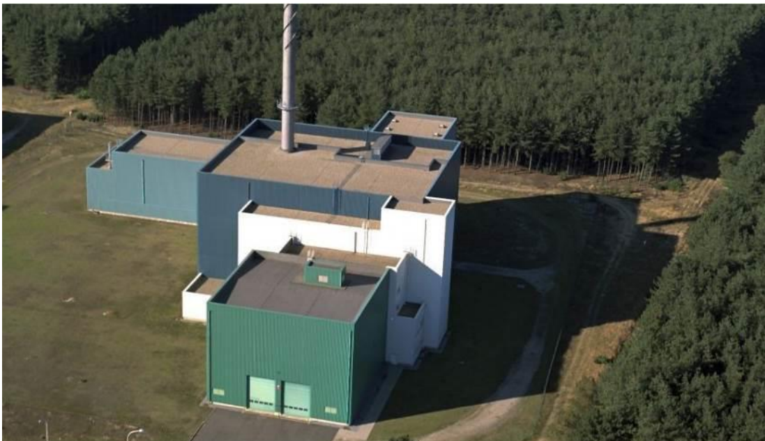
Figuur 14: Gebouw 136 voor de opslag van het afval afkomstig van de opwerking van verbruikte splijtstof
